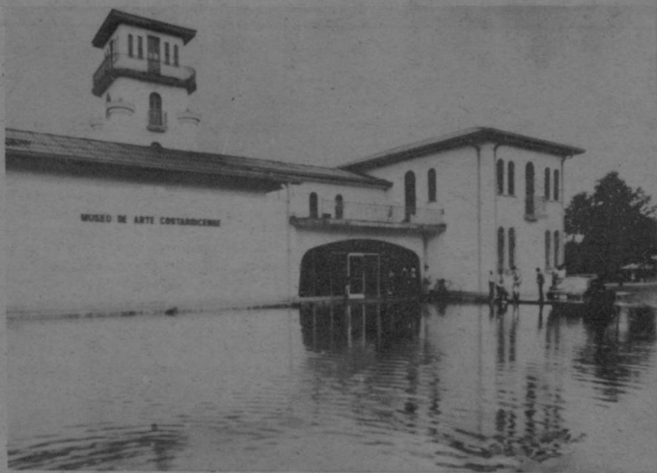
El Museo de Arte Costarricense (antiguo aeropuerto de La Sabana) quedó aislado por las fuertes lluvias de ayer al mediodía en San José. El agua afectó parte del edificio y al frente la calle y zona de estacionamiento quedó convertida en esta enorme y plácida laguna. (Laínez)
